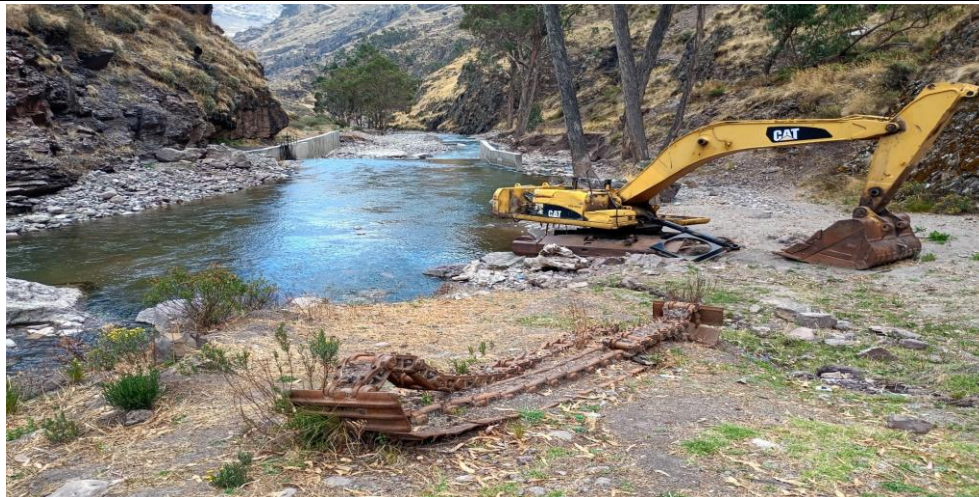
FIGURA N°01: EN EL BOCATOMA ESCARPADO SAN ISIDRO, EN EPOCA DE AVENIDA, EL RIO SAN JUAN (RIO HUICHINGA) AFECTA LA BOCATOMA DEL LUGAR POR LO QUE SE DEBEPROTEGER LA BOCATOMA, UBICADO EN AURAHUA - CASTROVIRREYNA - HUANCVELICA.
